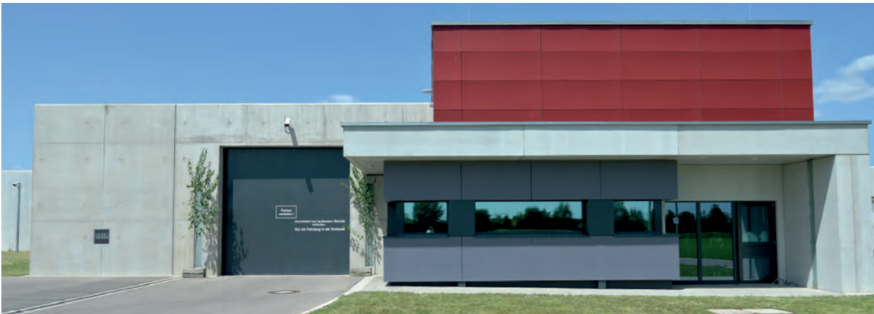
Neue Torwache mit Fahrzeugschleuse
